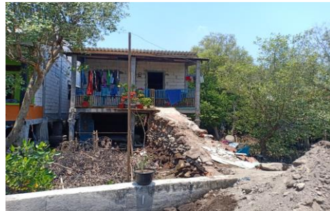
Merubah konstruksi rumah menjadi rumah panggung di Dukuh Bedono
