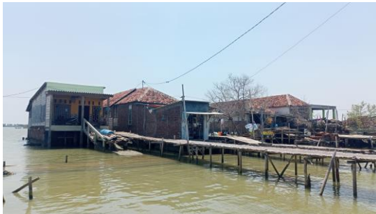
Merubah konstruksi rumah menjadi rumah panggung di Dukuh Pandansari
