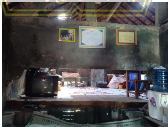
Gambar IV. 12 Meningkatkan Lantai Rumah Dengan Kayu
