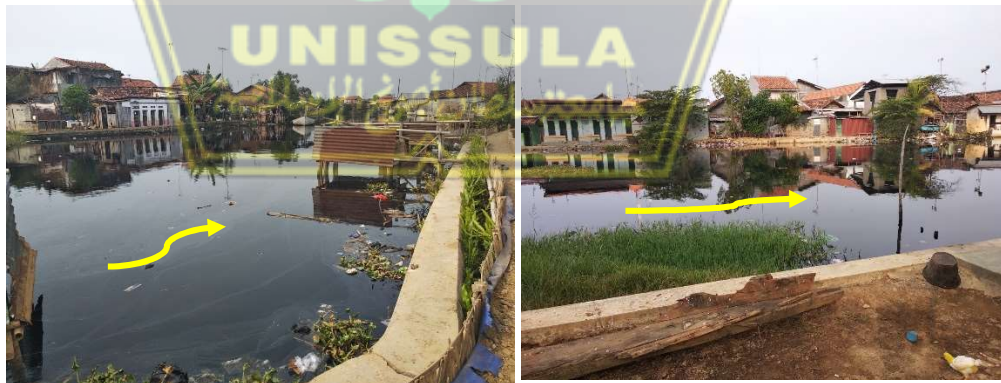
Gambar 5.1 Kondisi Sungai Loji dengan bangunan pada sempadan sungai di Pesisir Kota Pekalongan sebagai penyebab banjir (Dok. Pribadi,2022)
