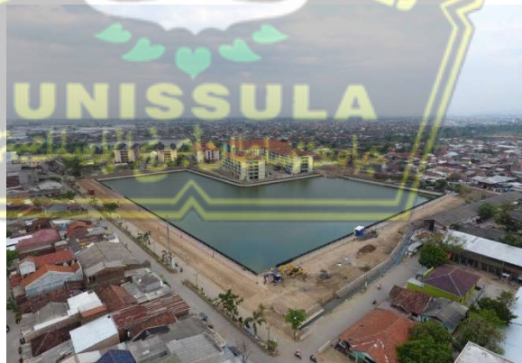
Gambar 2.8. Penanganan banjir dengan sistem Polder berupa kolam retensi di Semarang
