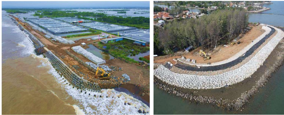
Gambar 5.24 Pekerjaan Tanggul pantai Degayu di Pesisir Pekalongan sebagai bentuk respon cepat pemerintah dalam upaya penanggulangan banjir
