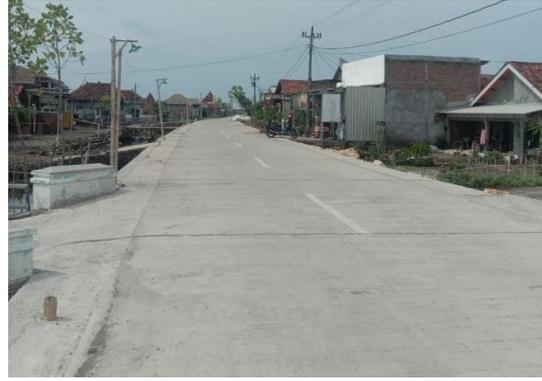
Kondisi jalan utama di Desa Surodadi yang sudah ditinggikan  $\pm$  1 meter dengan perkerasan beton karena sering tergenang banjir rob
