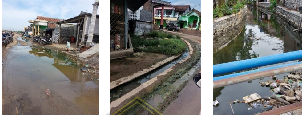
Gambar III.8 Kondisi Genangan Air dan Saluran Air bulan November
