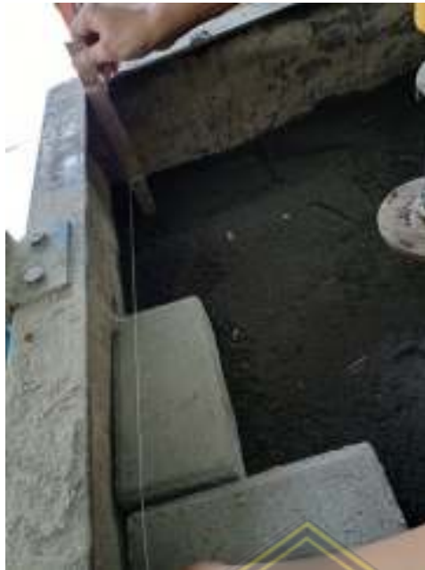
Gambar 3. 9 Pemasangan benang diatas permukaan paving
