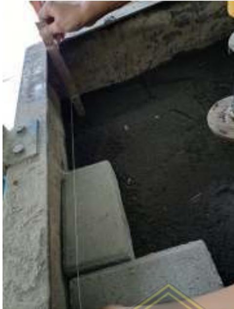
**Gambar 3. 9** Pemasangan benang diatas permukaan paving
