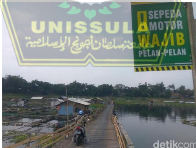
Gambar 2.5 Jembatan Apung Penghubung Desa Batujajar dan Desa Girimukti di Bandung Barat
