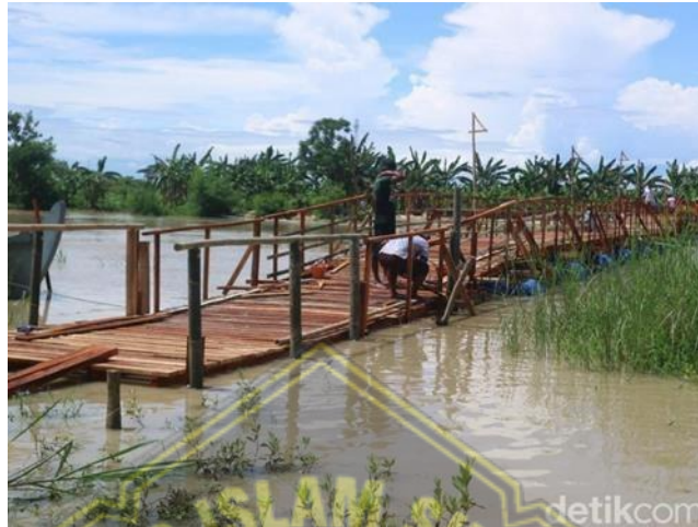
Gambar 2.2 Jembatan Apung di Sungai Wulan Kudus-Demak (Sumber : www.detik.com )
