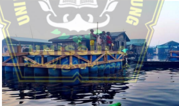
Gambar 2.2. Platform Apung dengan Drum Plastik
