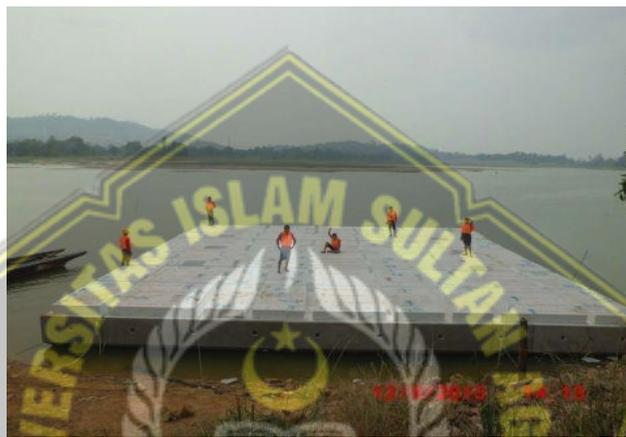
**Gambar 2.5.** Platform Apung dengan Styrofoam
