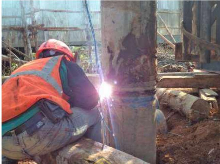
**Gambar 2.11** Proses Penyambungan *Spun Pile*
