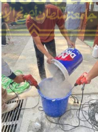
Gambar 3.15 Proses Pencampuran Semen dan Pasir
