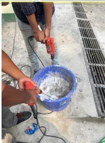
Gambar 3.18 Proses Pencampuran Mortar dan Busa Foam
