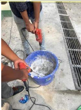
Gambar 3.18 Proses Pencampuran Mortar dan Busa Foam
