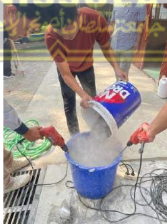
Gambar 3.15 Proses Pencampuran Semen dan Pasir
