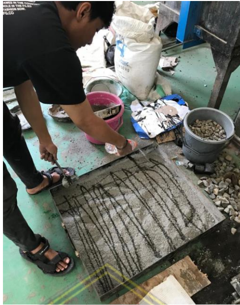
Gambar 3.15. Pencampuran Bahan Paving Block (Sumber : Data Primer, 2023)
