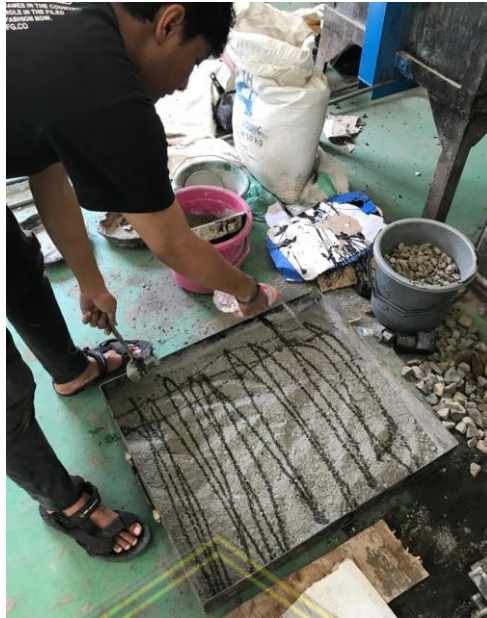
Gambar 3.15. Pencampuran Bahan Paving Block (Sumber : Data Primer, 2023)
