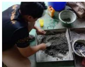
Gambar 3. 18 Pencampuran Bahan (Sumber: Dokumentasi Pribadi)
