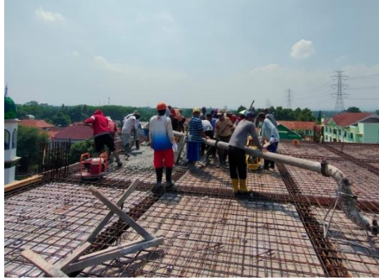
Gambar 2.7 Pekerjaan Pengecoran Pelat Beton
