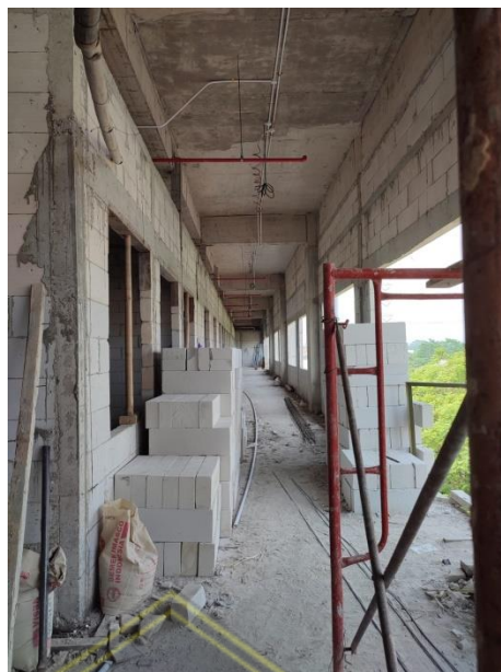
Gambar 4.16 Pekerjaan Pasangan Dinding Bata (Sumber: Data Primer, 2023)
