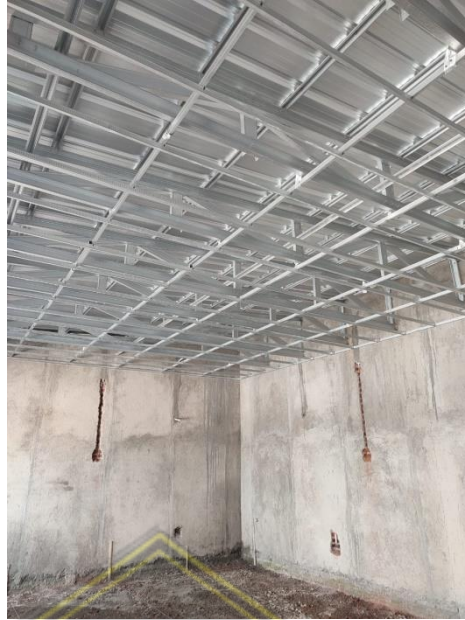
Gambar 4.17 Pekerjaan Rangka Plafon (Sumber: Data Primer, 2023)
