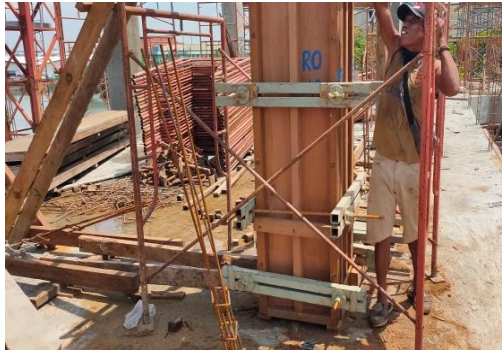
Gambar 2.3 Pekerjaan Bekisting Kolom
