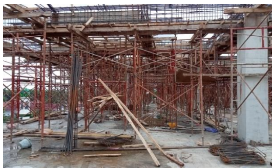
Gambar 2.5 Pekerjaan Penulangan Ring Balk
