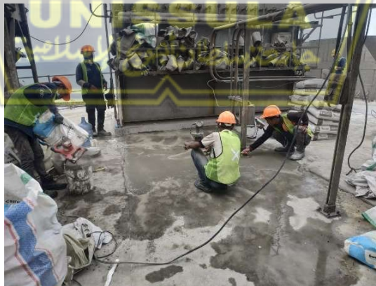
Gambar 4. 10 Levelling Permukaan Menggunakan Beton
