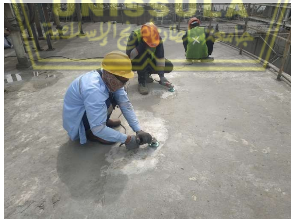
Gambar 4. 8 Pembongkaran Waterproof Existing
