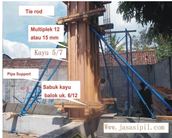
Gambar 2.2 Bekisting Konvensional (Sumber : www.jasasipil.com )
