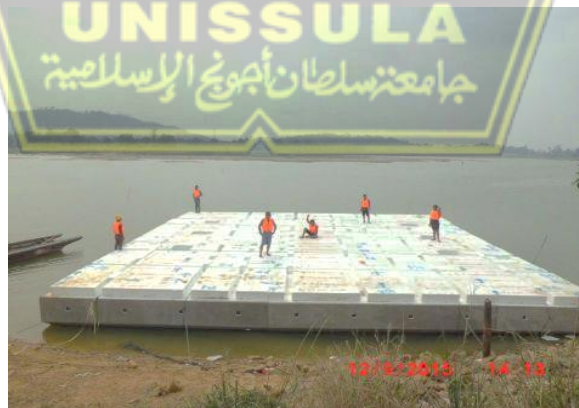
Gambar 2.7 Bangunan Apung Dengan Platform Styrofoam
