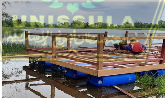
Gambar 2.3 Bangunan Apung dengan Platform Drum Plastik
