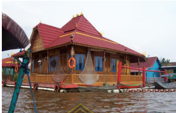
Gambar 2.6 Bangunan Apung dengan Platform PVC
