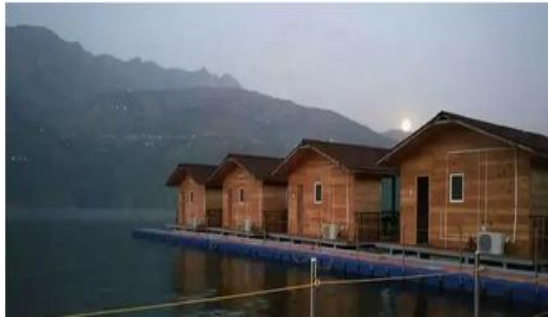
Gambar 2.4 Bangunan Apung dengan Platform Drum Plastik
