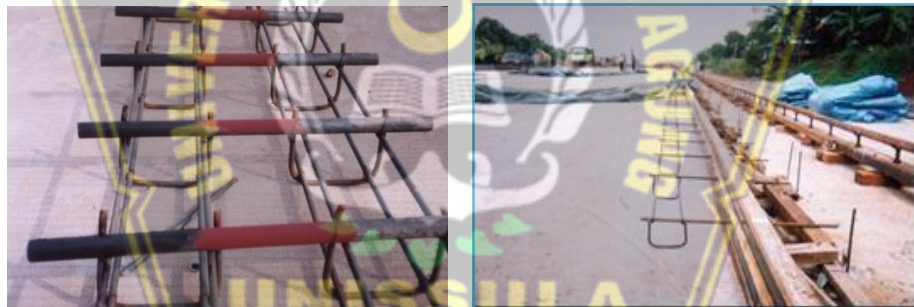
Gambar 2.4 Ruji dan Batang pengikat pada perkerasan kaku bersambung tanpa tulangan.
