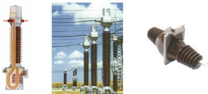
Gambar 2. 7 Contoh trafo arus pemasangan luar ruangan [17]
