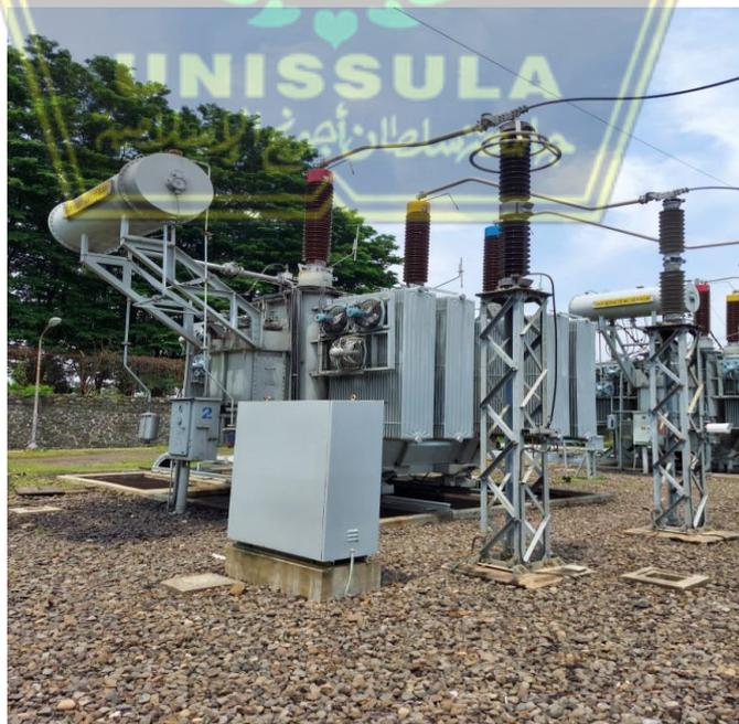
**Gambar 2. 3** Gambar Fisik Transformator 30 MVA
