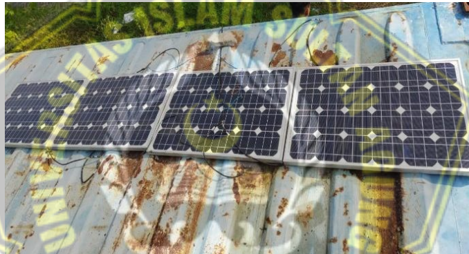
Gambar 3. 10 Panel Surya yang disusun secara paralel
