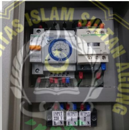
Gambar 3. 7 Panel Timer Kontaktor
