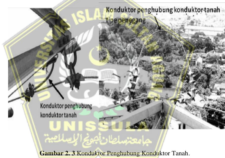
**Gambar 2. 3** Konduktor Penghubung Konduktor Tanah.
