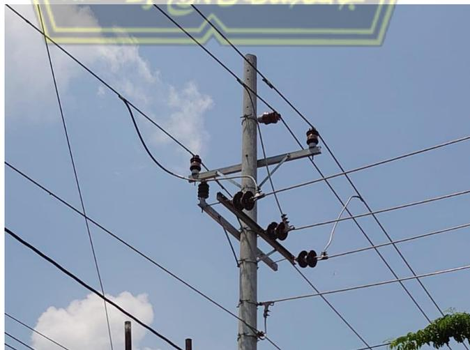
Gambar 2.12 Konstruksi Saluran Udara Tegangan Menengah
