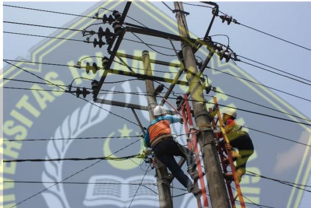
Gambar 2.13 Pemeliharaan Saluran Udara Tegangan Menengah
