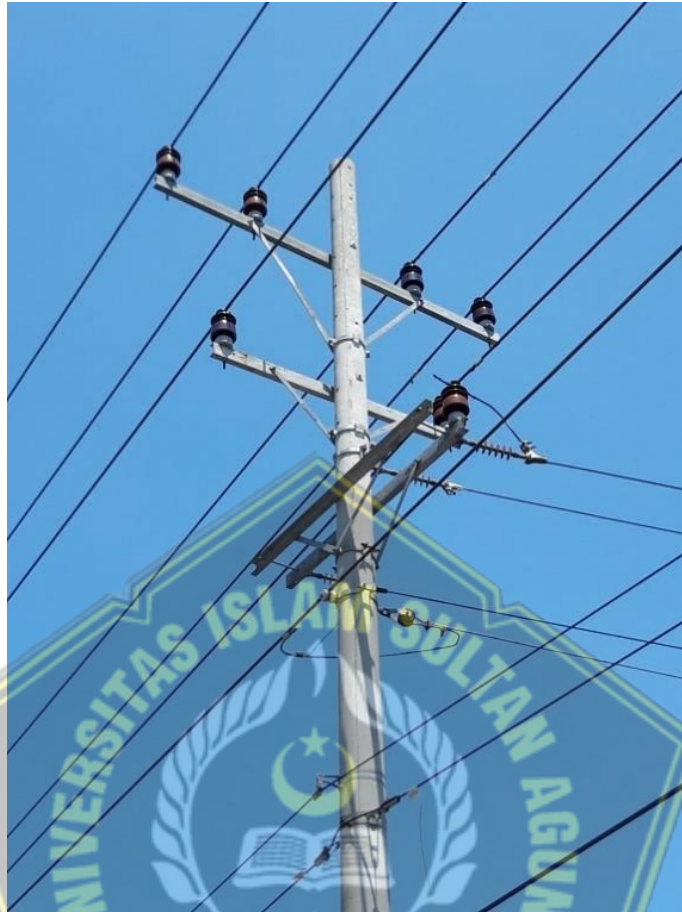
Gambar 2.7 Konstruksi Saluran Udara Tegangan Menengah
