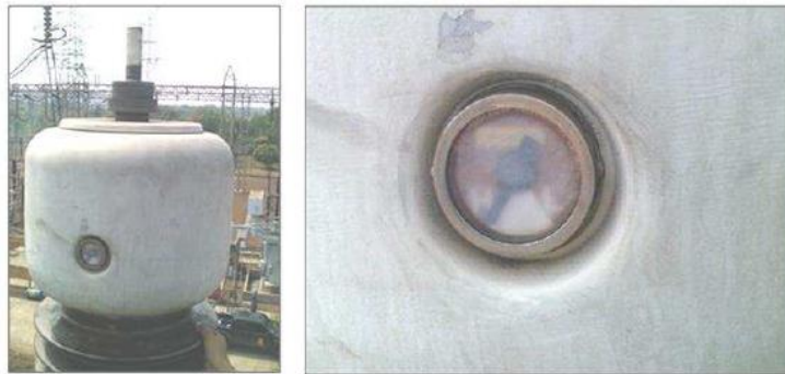
Gambar 2. 11 Indikator Level Minyak Bushing
