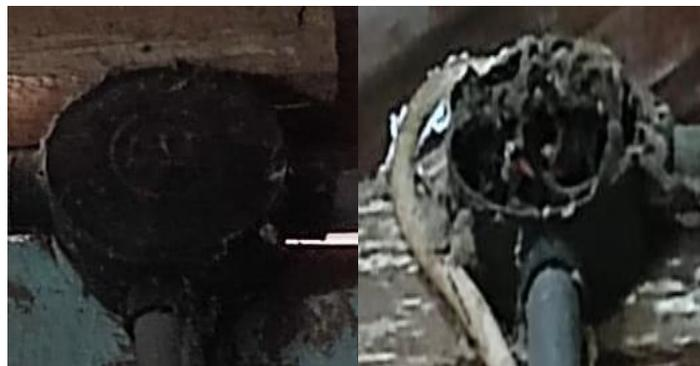
**Gambar 2. 8** Gambar Kotak Hubung Terbuka dan Tertutup
