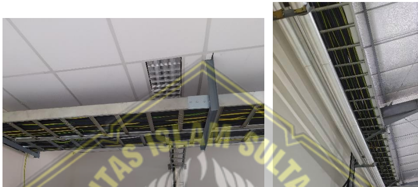
Gambar 2.20 Tray atau Rak Kabel
