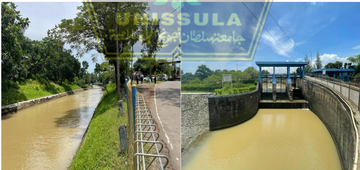
Gambar 4. 1. Kondisi D.I. Sungapan
