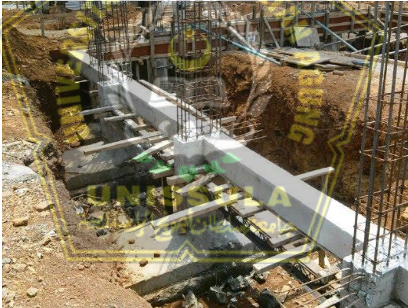
Gambar 2.8 Sloof Gantung (Sumber: www.adipranaindovesco.com )
