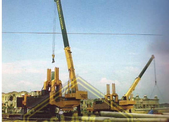
Gambar 2.14 Mesin Press in Pile ( Sumber : dokumen pribadi)
