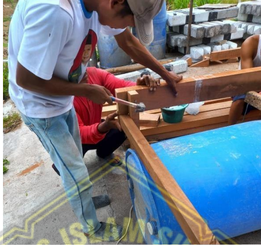
Gambar 4.15. Pemasangan Usuk
