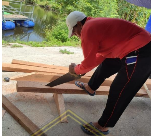
Gambar 4.9. Pemotongan Balok Kayu 6/12
