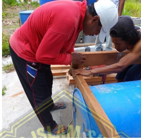
Gambar 4.13. Pemasangan Baut
