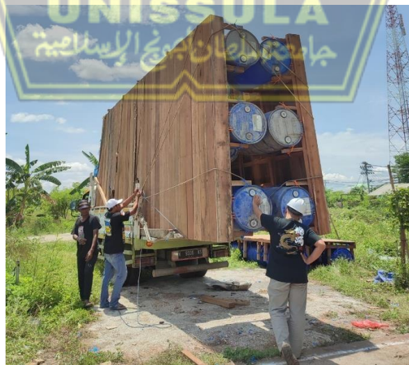
Gambar 4.20. Pengangkutan Platform Bangunan Pasar Apung (Sumber : Penulis, 2022)
