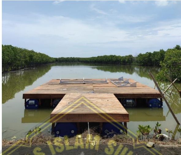
Gambar 4.21. Pemasangan Platform Bangunan Pasar Apung di Brebes
