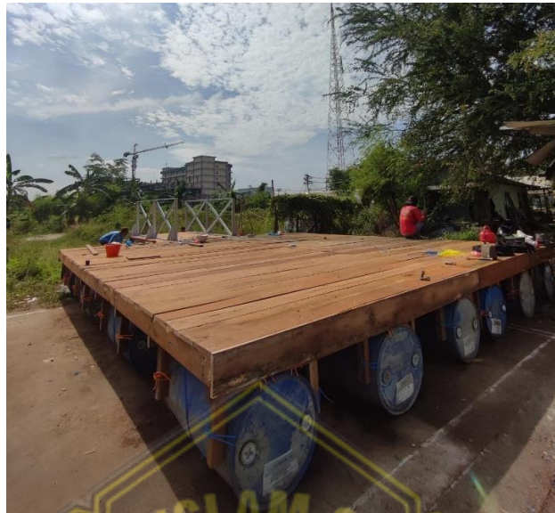
Gambar 4.19. Prototype Platform Bangunan Pasar Apung 6x6 m (Sumber : Penulis, 2022)
