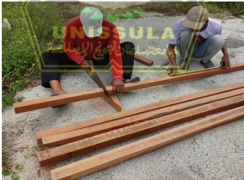
Gambar 4.14. Pemotongan Balok Kayu 5/7
