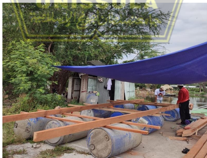
Gambar 4.12. Penataan Balok Kayu
