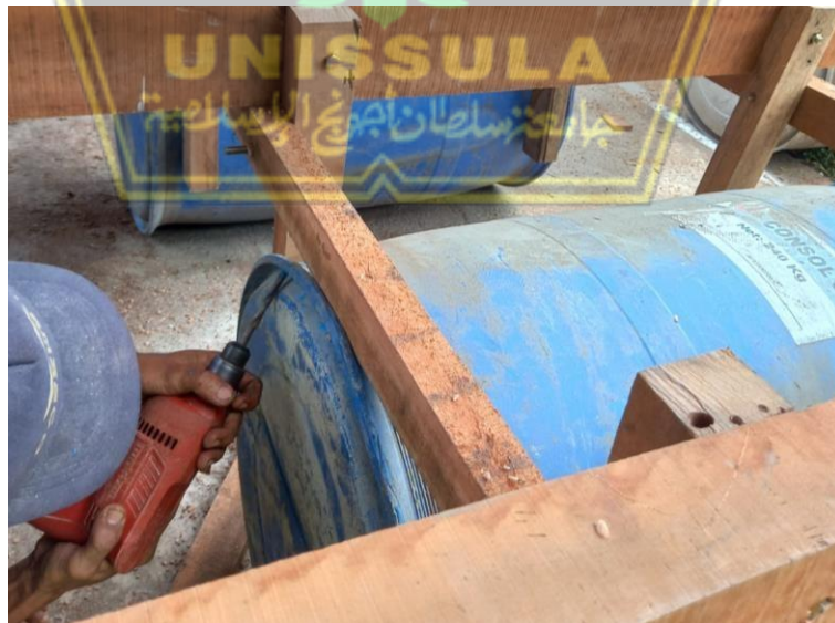
Gambar 4.16. Pemasangan Sekrup
