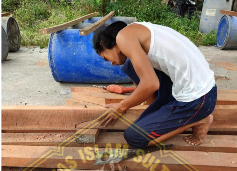
Gambar 4.11. Penyambungan Balok Kayu
