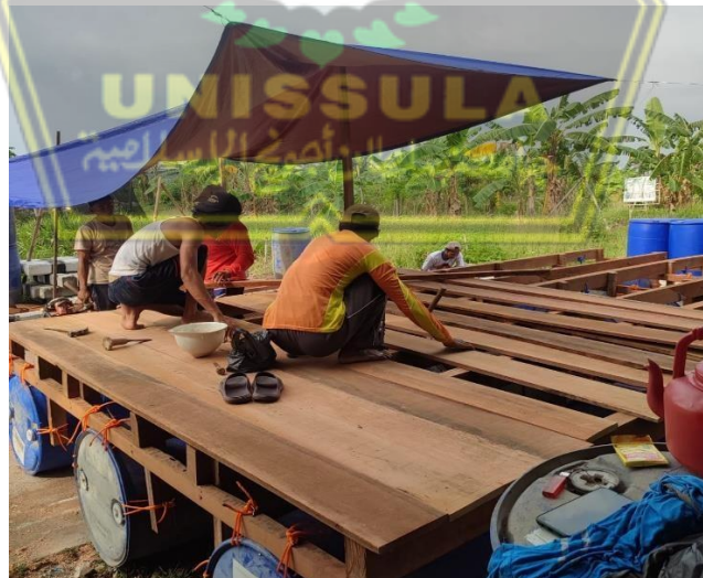
Gambar 4.18. Pemasangan Papan Kayu
