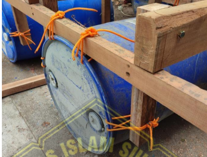
Gambar 4.17. Pemasangan Tali Tambang
