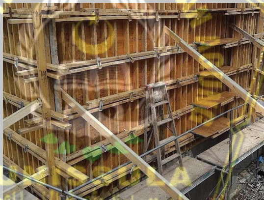
Gambar 2.2 Bekisting Konvensional
