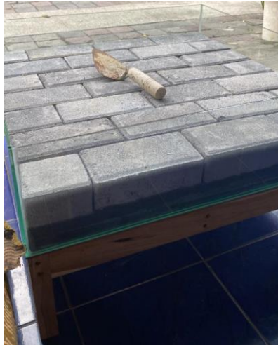
Gambar 3.27. Pemasangan paving block
