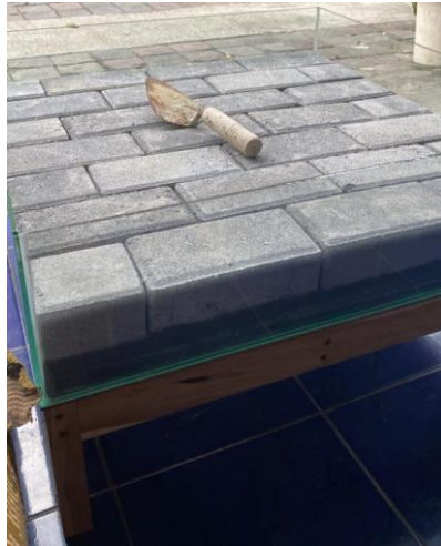
Gambar 3.27. Pemasangan paving block
