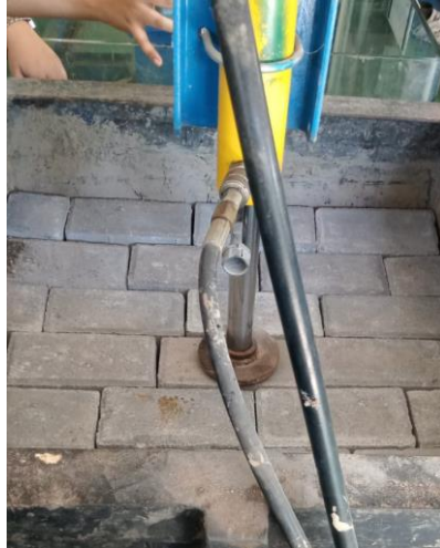
Gambar 3.19. pemasangan paving block berukuran 20 x 10 x 6 cm
