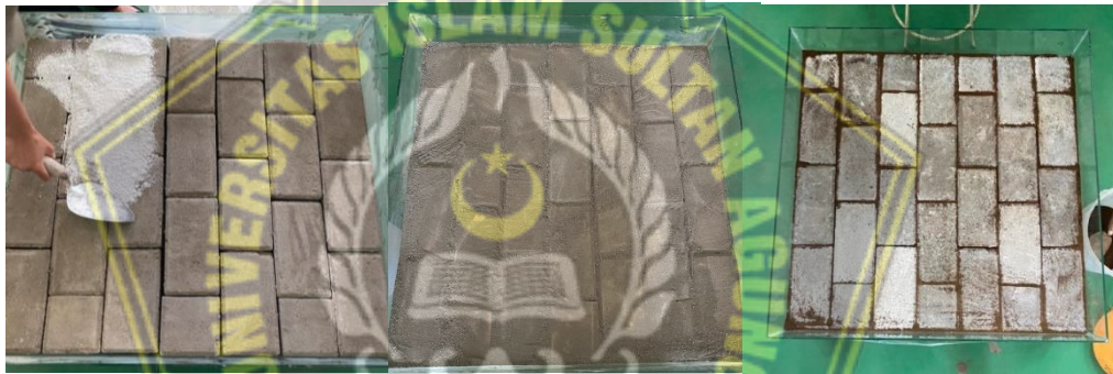
Gambar 3.28. Pengisian jointing dengan pasir dengan abu kapur, pasir dan lempung, kemudian tanah urug
