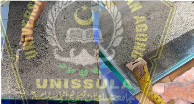
Gambar 3.26. Penghamparan pasir dengan ketebalan 5 cm dengan kemiringan sebesar 2%
