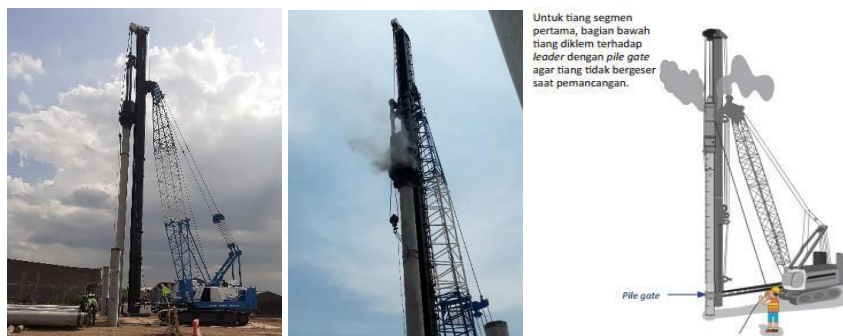
Gambar 2.10 Proses Pemancangan Spun Pile. ( Sumber : https://binamarga.pu.go.id/ )
