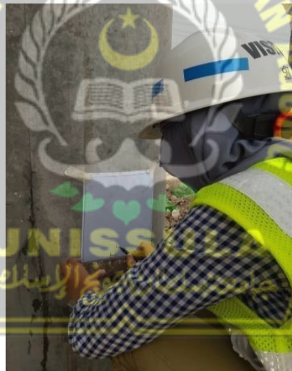
Gambar 2.12 Proses Kalendering Spun Pile. ( Sumber : dokumen pribadi )
