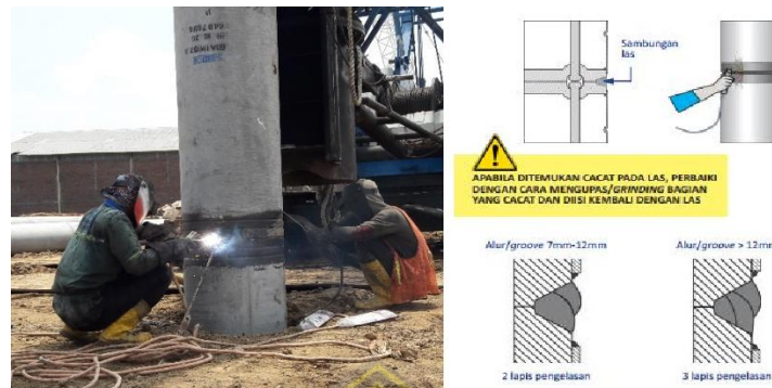
Gambar 2.11 Proses Penyambungan Spun Pile. ( Sumber : wika jalan tol semarak )
