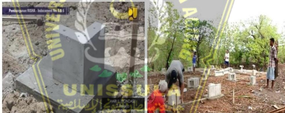
**Gambar 4.9** Pemasangan panel penyambung (P3) pada pondasi
