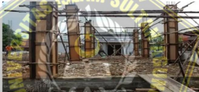
**Gambar 4.4** Pekerjaan Kolom
