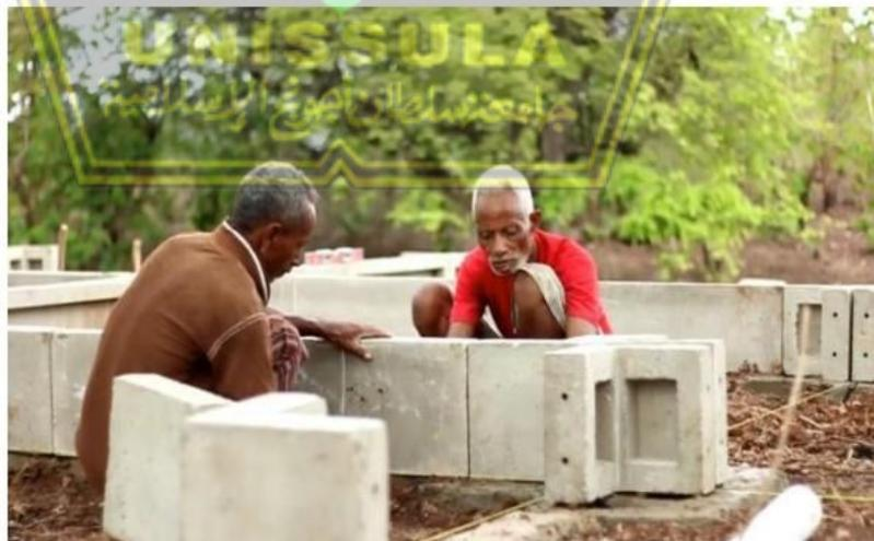
**Gambar 4.11** Pemasangan balok sloof
