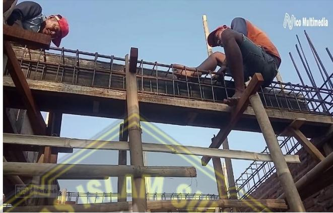
**Gambar 4.6** Pekerjaan Ring Balok
