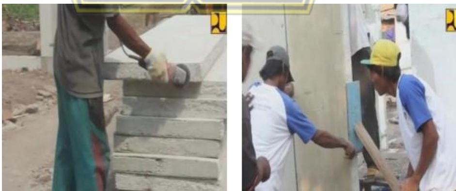
**Gambar 2.11** Dinding Pracetak dan Pemasangannya
