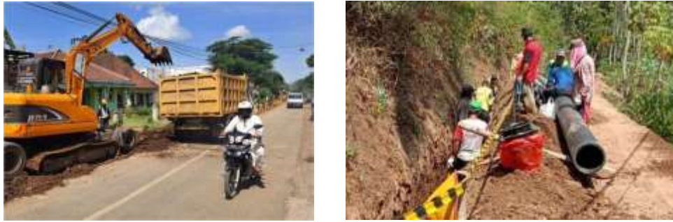
Gambar 4. 6 Contoh Pekerjaan Open cut (Sumber : Dokumentasi Hasil Observasi)
