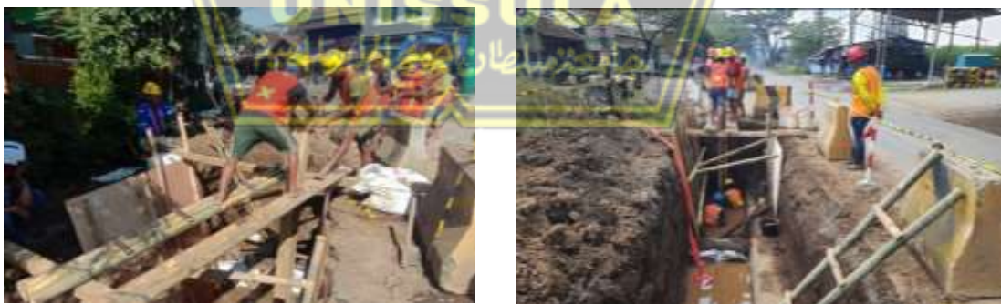
Gambar 4. 7 Contoh Pekerjaan Boring Horizontal Manual (Sumber : Dokumentasi Hasil Observasi)
