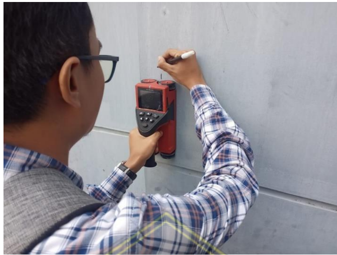
Gambar 4.5 Pengujian Rebar Detector
