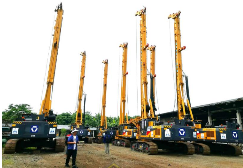
Gambar 2.3 Pondasi Borepile Menggunakan Alat Mini Crane (Sumber: www.sumurborsolo.com )
