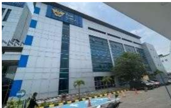
Gambar 4.1. Tampak Bangunan Bea Cukai Tanjung Emas
