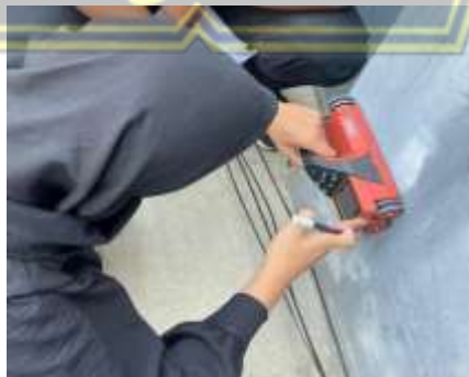
Gambar 3.9. Pengecekan Tulangan dengan Alat Rebar Detector
