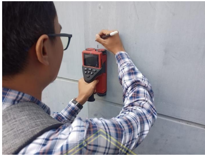
Gambar 4.5 Pengujian Rebar Detector
