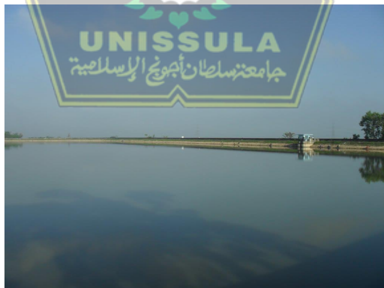
Gambar 2.2. Bendungan Blimbing, Jawa Tengah
