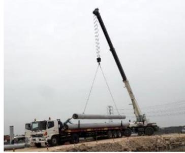
**Gambar 4.13.** Penurunan *Spun Pile* di *Site*
