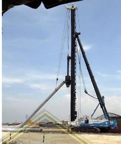
**Gambar 2.7.** *Diesel Hammer*
