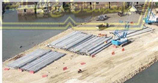
**Gambar 4.24.** Penurunan *Spun Pile* di Site
