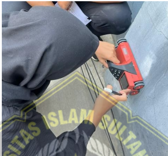
Gambar 4.8. Uji Rebar Detector
