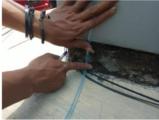
Gambar 4.10. Pengukuran Level Bangunan
