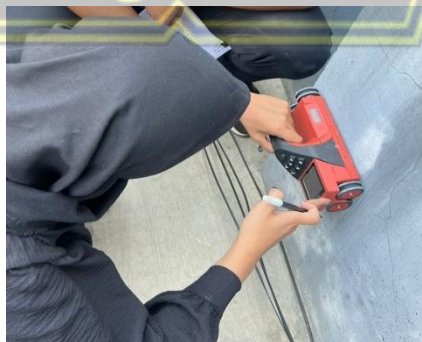
Gambar 3.9. Pengecekan Tulangan dengan Alat Rebar Detector
