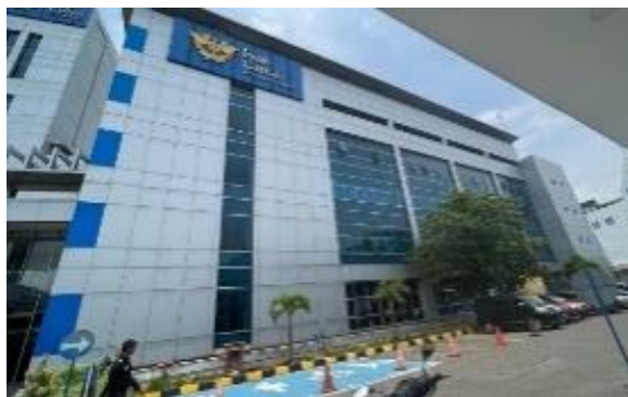
Gambar 4.1. Tampak Bangunan Bea Cukai Tanjung Emas
