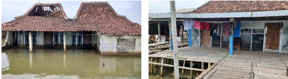
Gambar 4. 10 Kondisi Bangunan rumah yang ditinggikan
