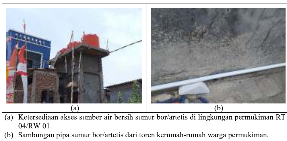
Gambar 4. 19. Ketersediaan Sumber Air Bersih Lingkungan Permukiman Terdampak Rob di Wilayah RW 01
