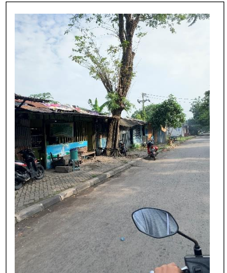
Jalan Terminal dengan kelas jalan lokal yang memiliki lebar jalan \pm 7 meter.
